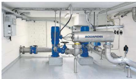
Die Sanierung des Grundwasserpumpwerks Herbrig wird demnächst abgeschlossen. Bild: PD
